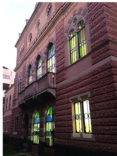
Figura 1.1 - Vista della facciata esposta a Nord-Est
