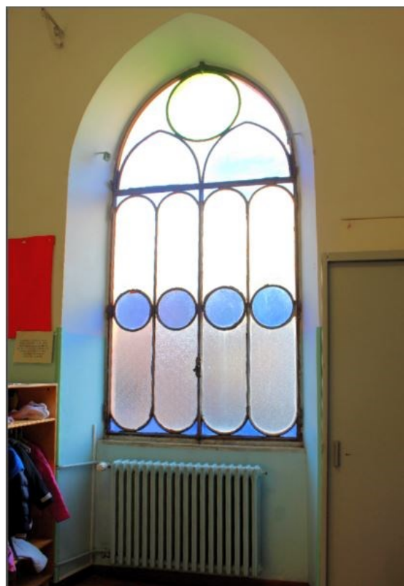
Figura 4.3 - Particolare dei serramenti
