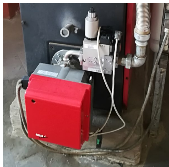
Figura 4.7 - Particolare del bruciatore R.B.L Gulliver BS4D
