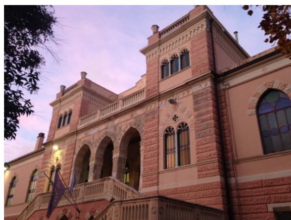
Figura 4.2 - Particolare della facciata esposta a Sud Ovest
