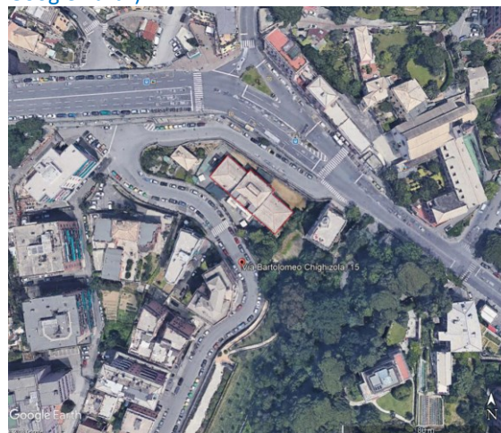
Figura 2.2 - Vista satellitare dell’edificio (Fonte: Google Earth)
